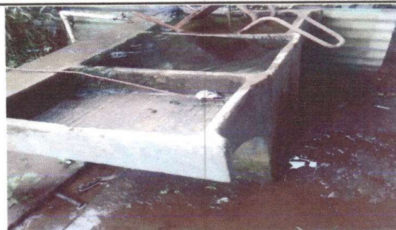
Foto 4: Sustitución de llaves de chorro.
