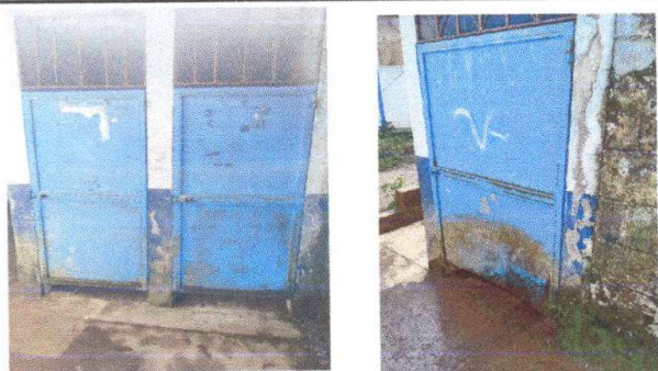
Foto1: Mantenimiento a estructura puertas de baños.
