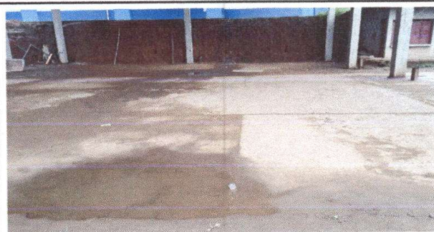
Foto 6: Sustitución de piso torta de concreto en cancha.
