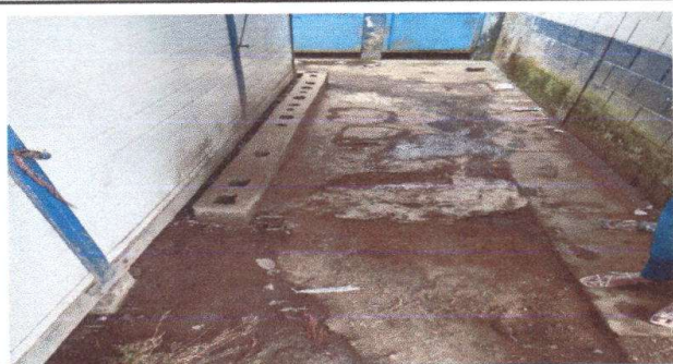
Foto 5: Sustitución de piso torta de concreto.
