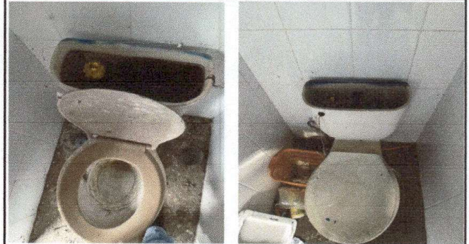
Foto 8: Sustitución de inodoros y accesorios.
