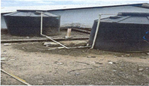
Foto 7: Sustitución de cisternas de agua.
