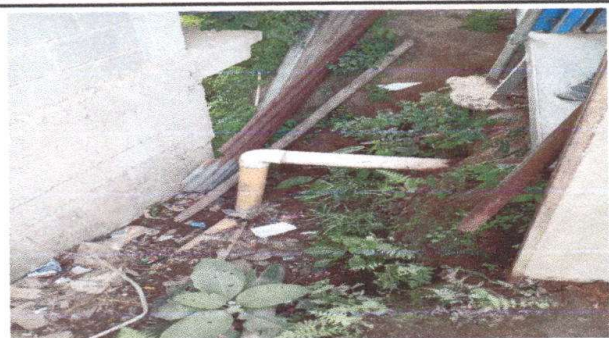
Foto 3: Sustitución de tubería pvc, para aguas negras.
