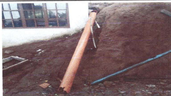
Foto 2: Sustitución de tubería pvc, líneas para aguas pluviales.
